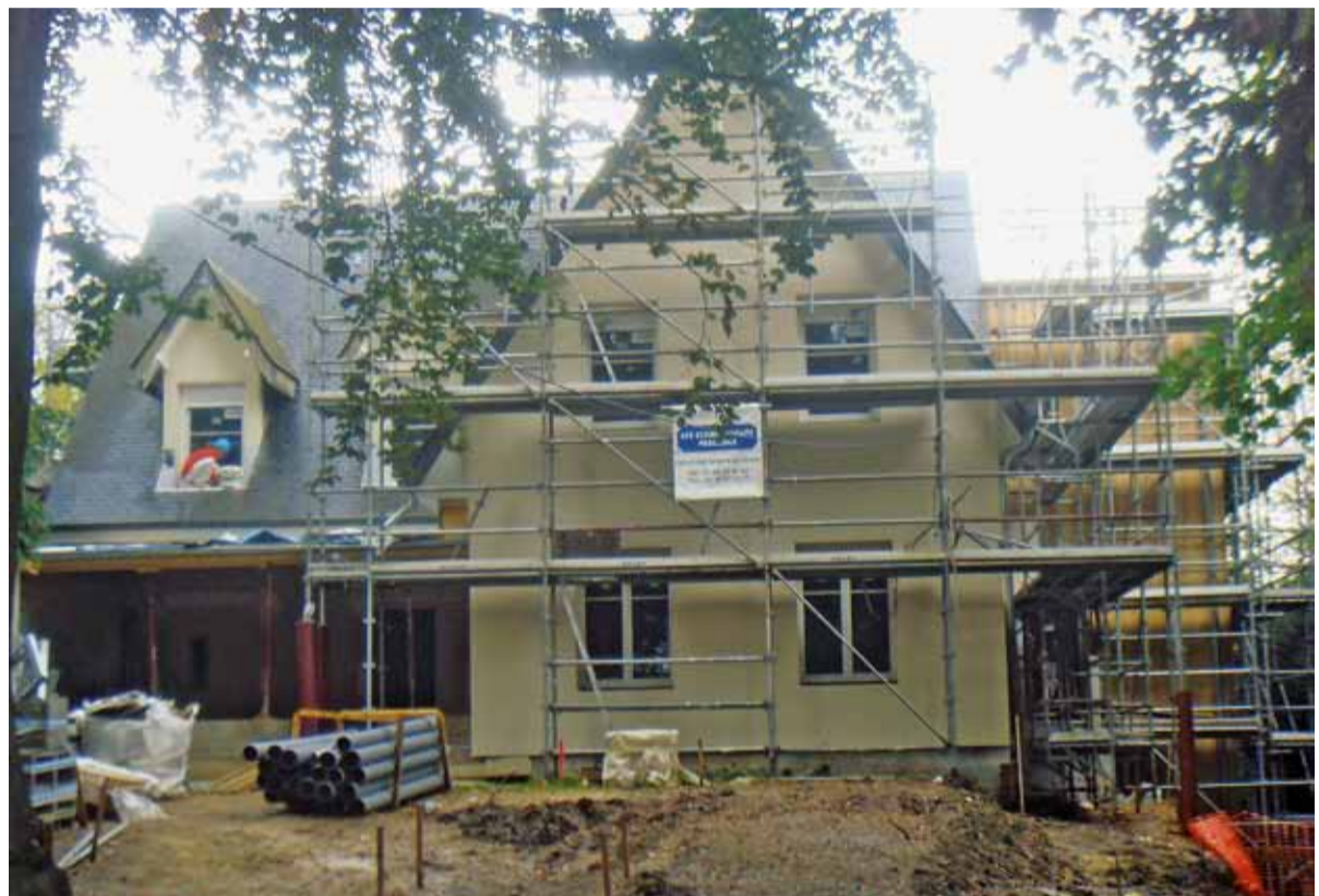
La Villa d'Avray en chantier.
