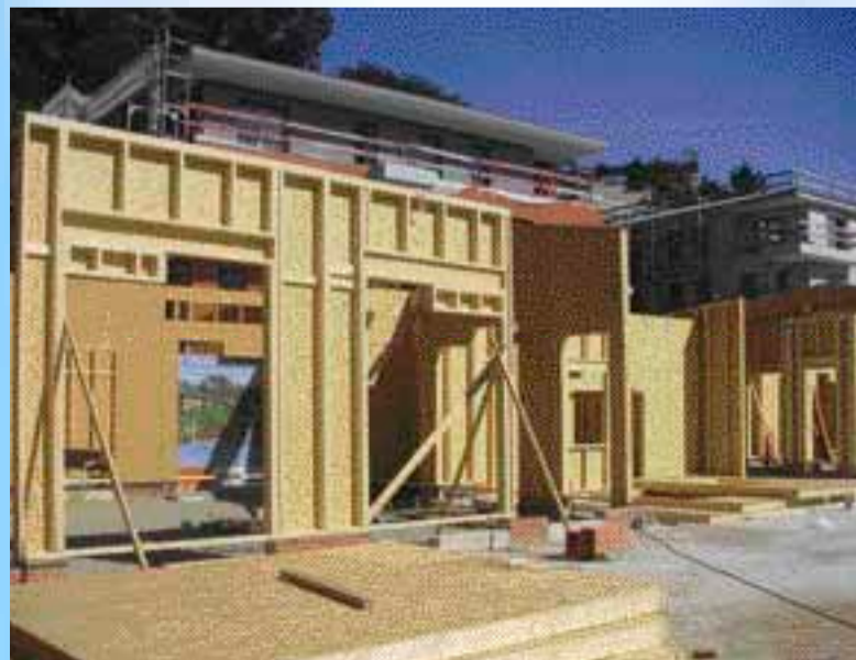
La future crèche 18, rue de Marnes : les murs en structure bois, 1 er élément d'une construction Haute Qualité Environnementale, en ligne avec la politique de Développement durable engagée par la municipalité.
